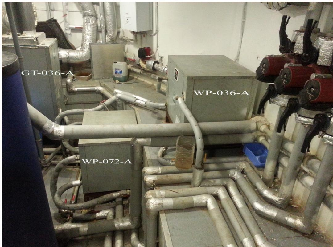
Рисунок 5.3 - Фотография тепловых насосов, установленных в жилом доме по ул. Земляничная, 17 в г. Владивостоке.
