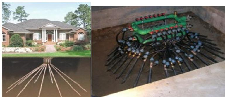
Рисунок 1.7 - Наклонные грунтовые теплообменники.
