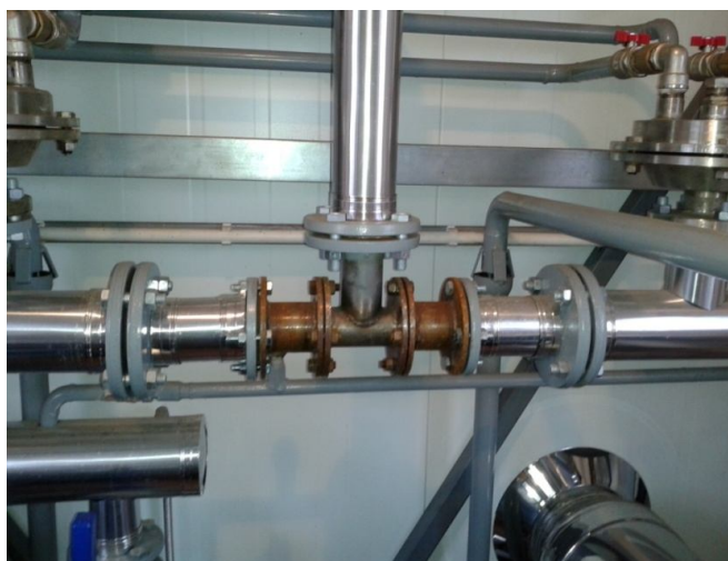
Рисунок 5.1 – Преобразователь потока в ИТП учебного корпуса Ковылкинского филиала ФГБОУ ВПО «МГУ им. Н. П. Огарева»
