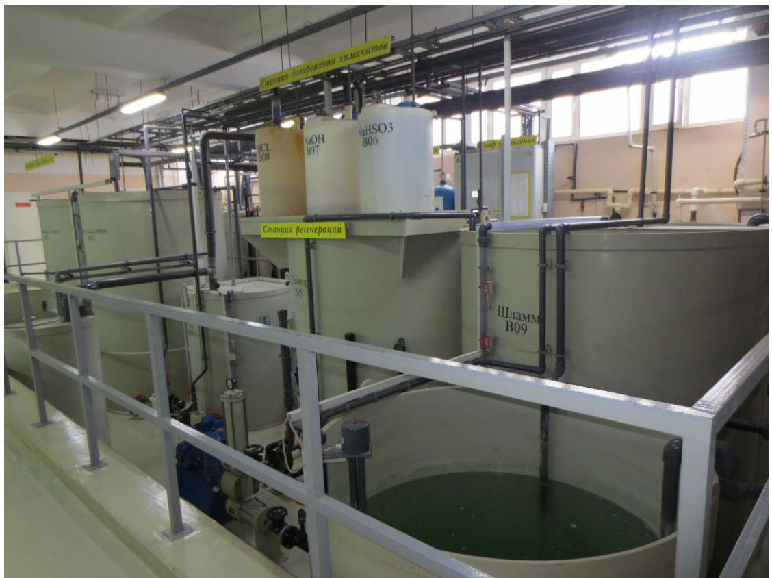
Рисунок 5.2. Общий вид локальных очистных сооружений АО «НПП «Рубин».
