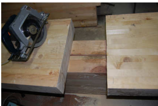
Рисунок 4.6 – Вырез «четвертей» под соединительный сварной элемент
