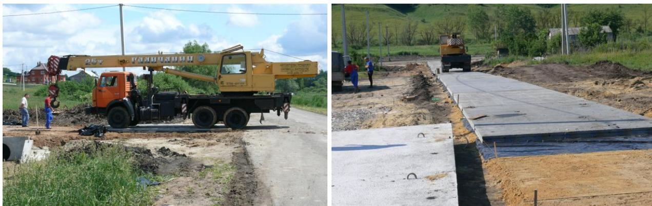
Рисунок 69 – Монтаж дорожных плит автокраном
