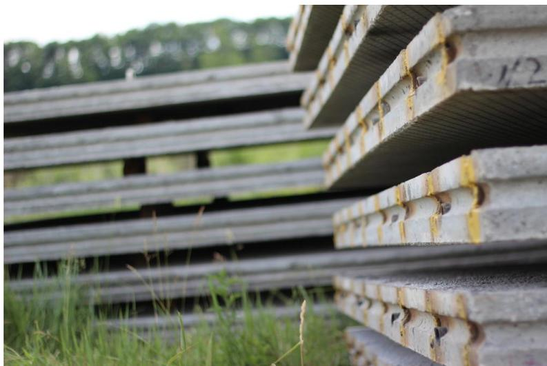
Рисунок 67 – Железобетонные плиты перед укладкой в дорожное полотно
