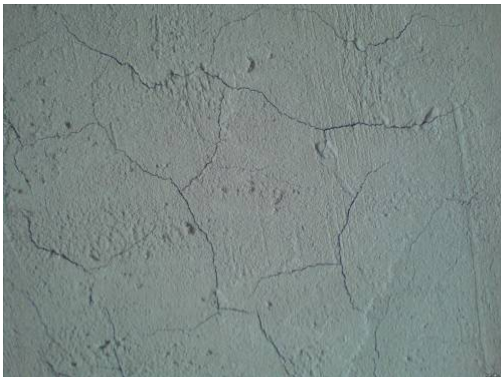
Рисунок 5.1 – Фотография фасада здания по улице Циолковского, г. Пенза, после первого года эксплуатации покрытия
