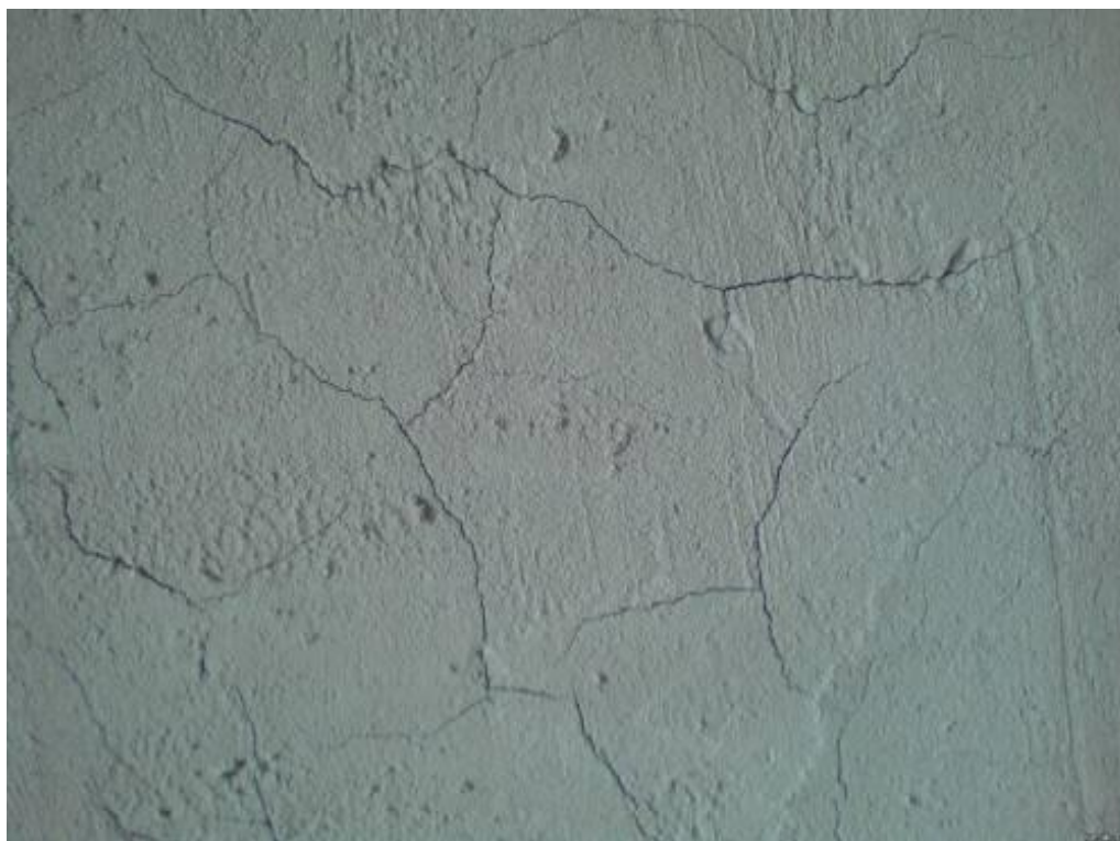
Рисунок 5.1 - Фотография фасада здания по улице Циолковского, г.Пенза, после первого года эксплуатации покрытия
