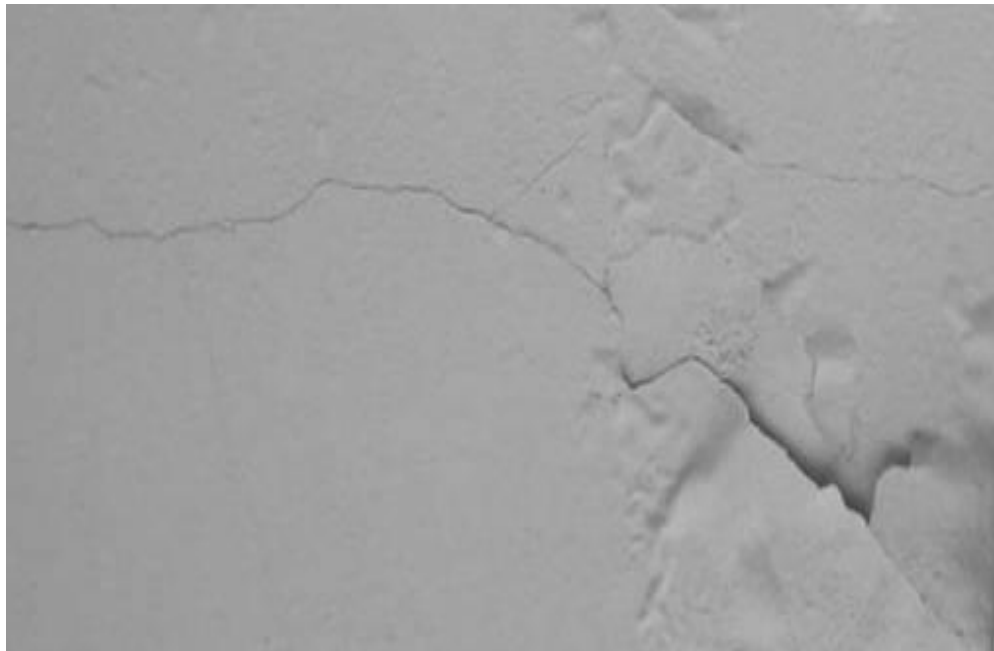
Рисунок 5.3 – Фотография фасада здания по улице Циолковского, г.Пенза, после трех лет эксплуатации покрытия
