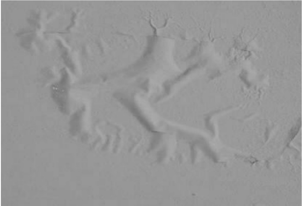
Рисунок 5.2 - Фотография фасада здания по улице Циолковского, г.Пенза, после первого года эксплуатации покрытия
