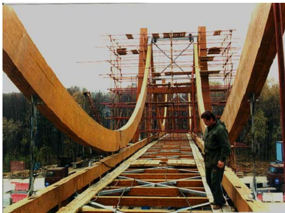
Рисунок 1.19 – Ванты пешеходного перехода на МКАД, элементы которых соединены жестким растянутым стыком на вклеенных V-образных анкерах
