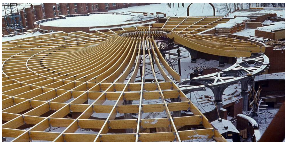
Рисунок 1.15 – Купол со стыками на клеенных стержнях
