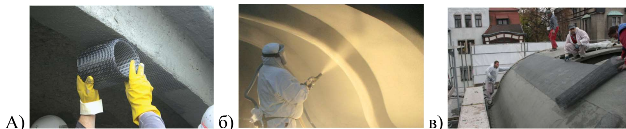
Рисунок 1.8 – Усиление текстиль-бетоном крыши исторического здания:
