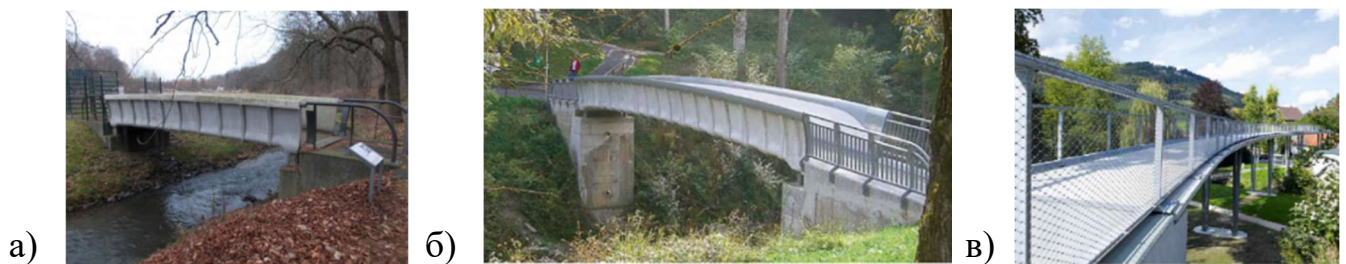
Рисунок 1.9 – Мосты из текстиль-бетона: а) мост в городе Ошатц [35], б) мост в городе Кемптен [35], в) мост в городе Албштадт-Лаутлинген [45]
