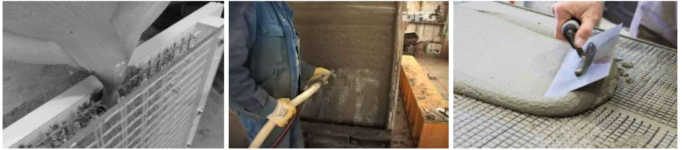
Рисунок 1.15 – Приготовление текстиль-бетона с использованием разных консистенций бетонной смеси [62]
