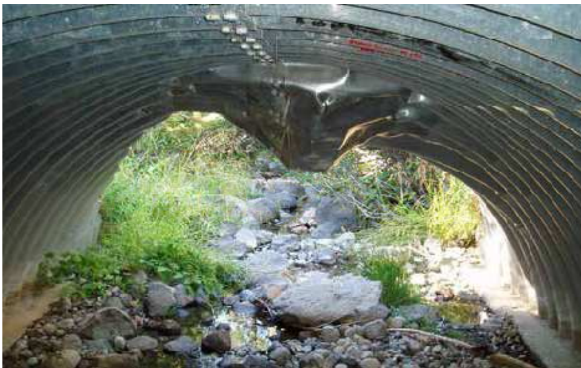
Рисунок 1.6 – Деформации гофрированных листов МГК
