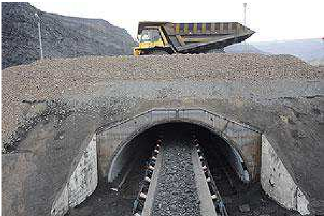
Рисунок 1.3 – Арочная конвейерная галерея из гофрированных листов
