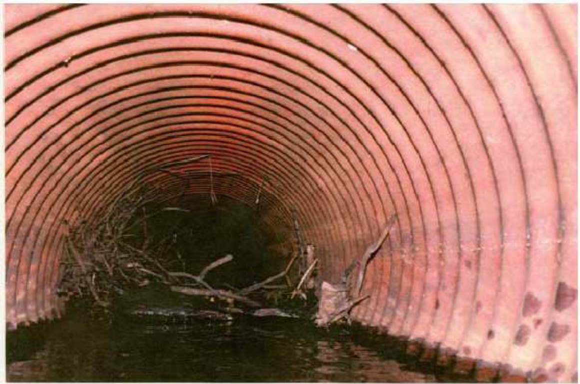
Рисунок 1.12 – Бобровая плотина в отверстии водопропускной трубы из МГК
