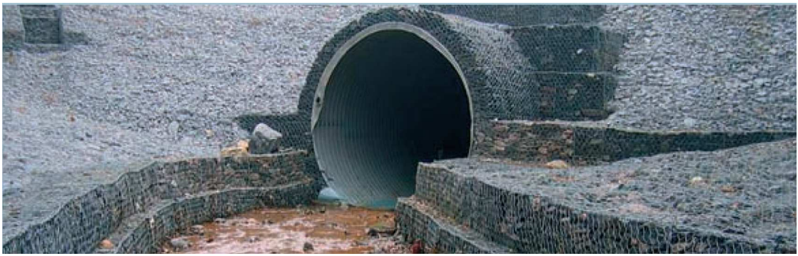
Рисунок 1.1 – Водопрпускная труба круглого сечения из гофрированных листов
