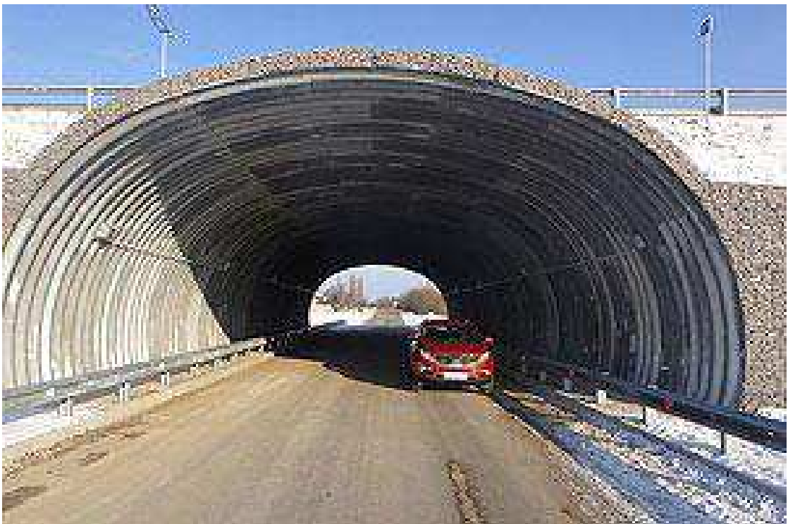
Рисунок 1.2 – Арочный путепровод из гофрированных листов
