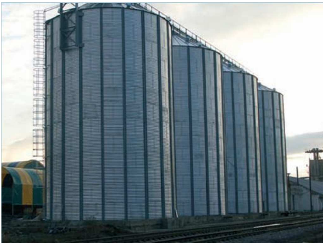
Рисунок 1. 4 – Силосы из гофрированных листов
