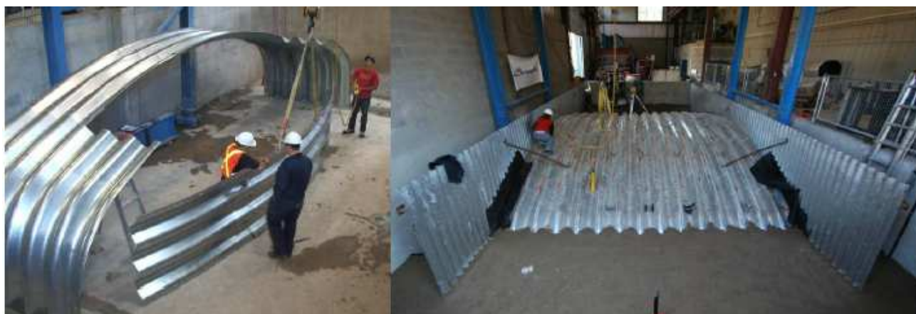
Рисунок 2.7 – Возведение сооружения и засыпка свода
