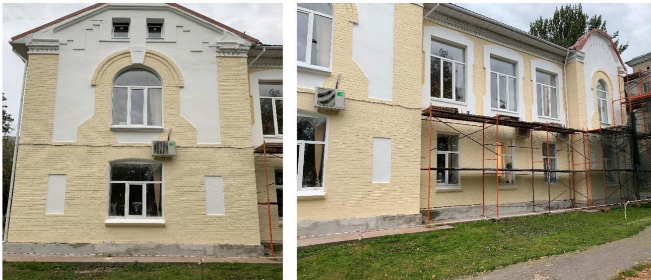
Рисунок 5.22 – Фасад зданий, окрашенный с использованием золь-силикатной краски (г. Коломна, Московская область)
