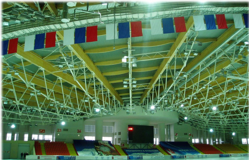
Рисунок 1.10 – Применение деревометаллических ферм с узлами на клеенных стержнях для покрытий конькобежного центра в Крылатском
