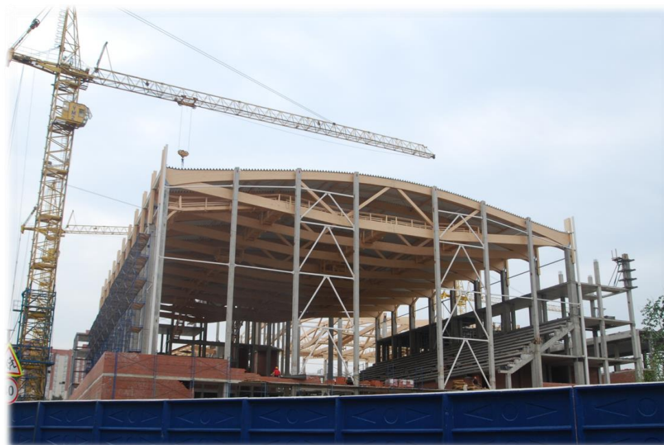
Рисунок 1.9 – Покрытие бассейна «Невская волна» из клееных ферм пролетом 45 м (г. Санкт-Петербург)
