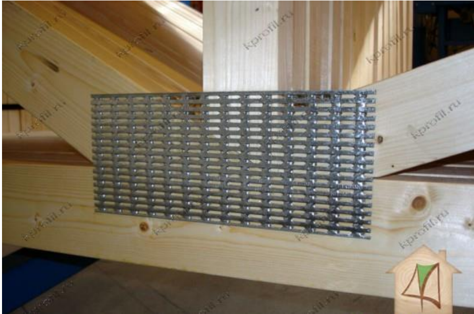
Рисунок 1.14 – Сопряжение элементов деревянной фермы на МЗП
