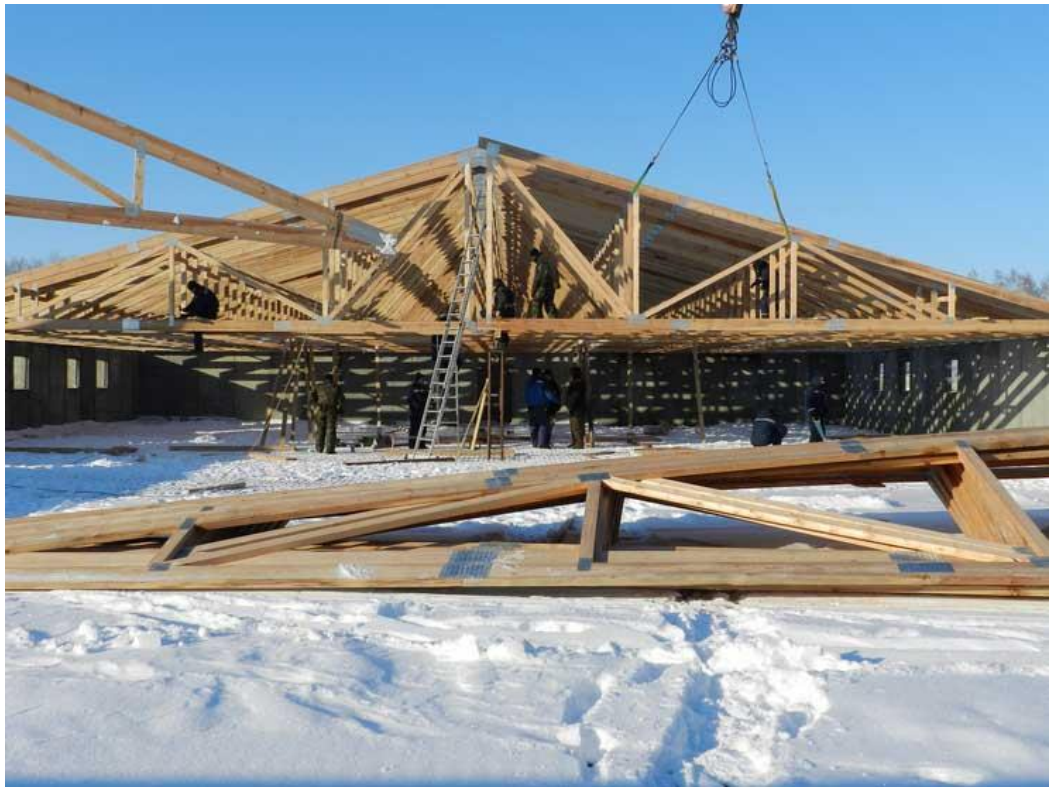
Рисунок 1.1 – Монтаж треугольных деревянных ферм покрытия сельскохозяйственного здания
