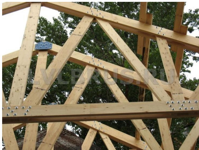
Рисунок 1.6 – Дощатые фермы с соединениями на нагельных болтах
