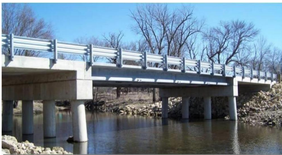
Рис 1.1. Мост «Jakway Park Bridge», США, округ Бьюкенен, штат Айова [154,159]
