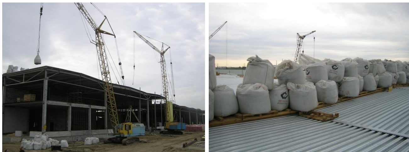
Рис. 4.12 - Нагружение конструкций штучным грузом
