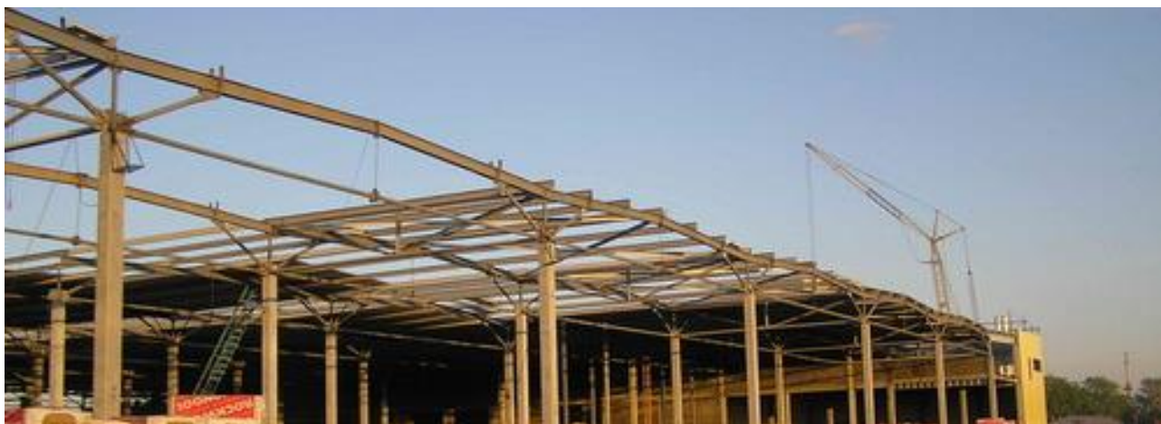
Рис. 4.1 - Строительство здания гипермаркета с применением новых металлических конструкций покрытия (вид на первый и второй блоки)
