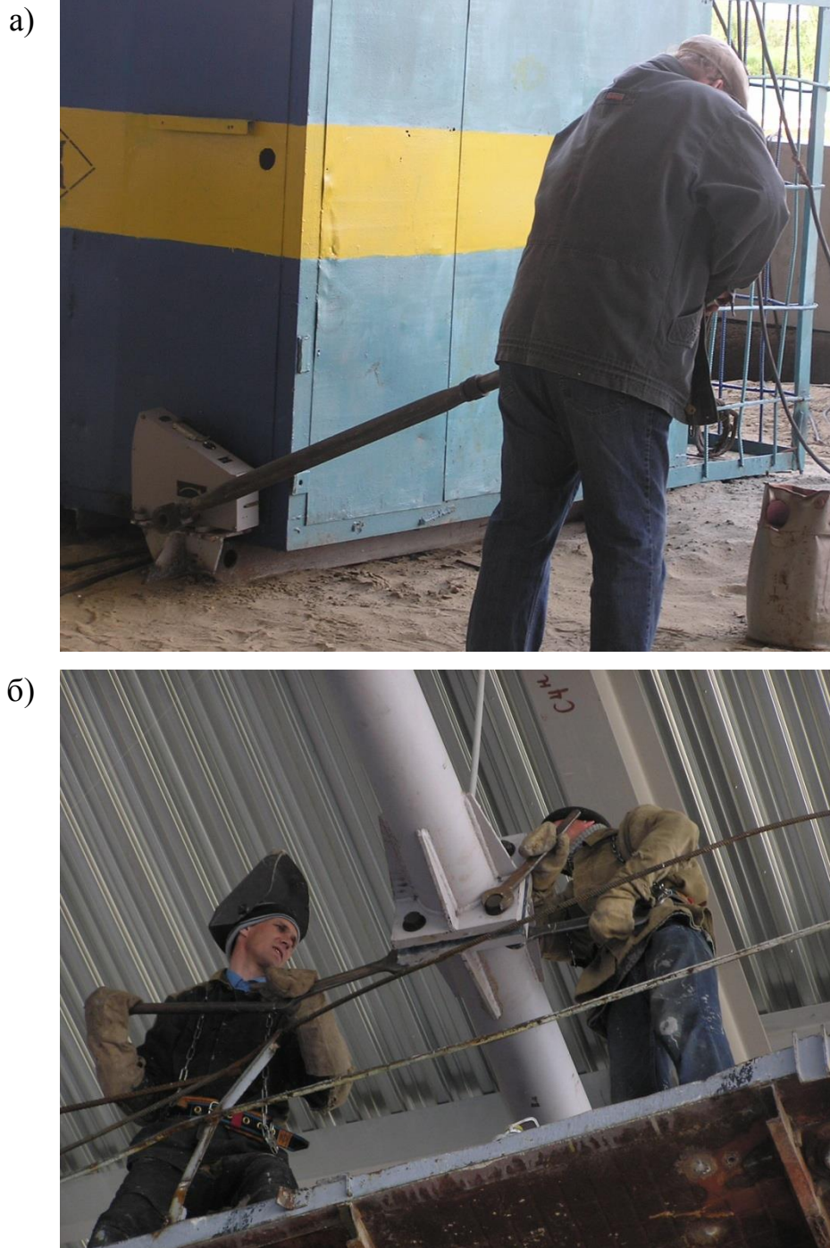
Рис. 4.10 – Натяжение болтов в соединении затяжки ключом сигнального типа
