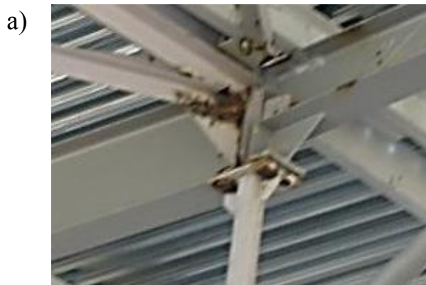
Рис. 4.9 – Монтажные узлы надколонника и затяжки с предварительно фиксируемым зазором
