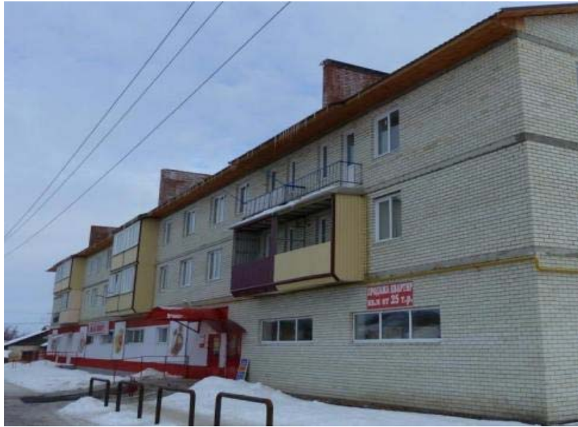
Рисунок 2.10 – Общий вид на главный фасад дома по ул. Коммунистической, 57 в г.Каменке Пензенской области
