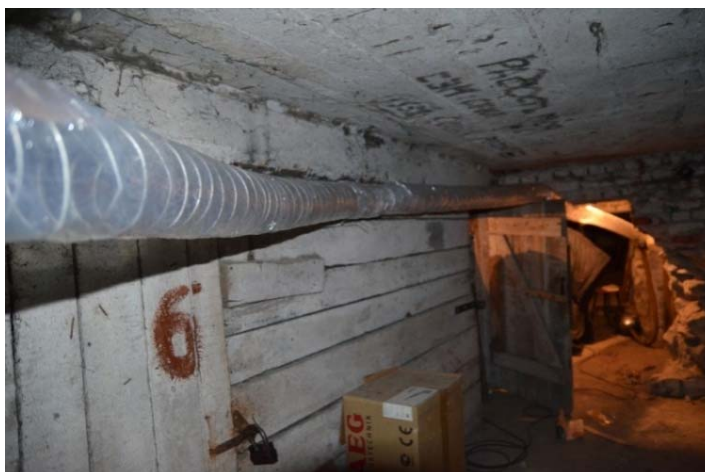
Рисунок 4.1 – Установка воздуховода в подвальном помещении
