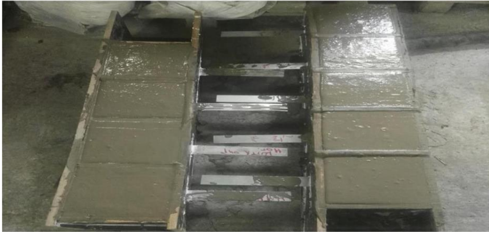
Рисунок 2.9 – Забивка ячеистым бетоном опалубки
