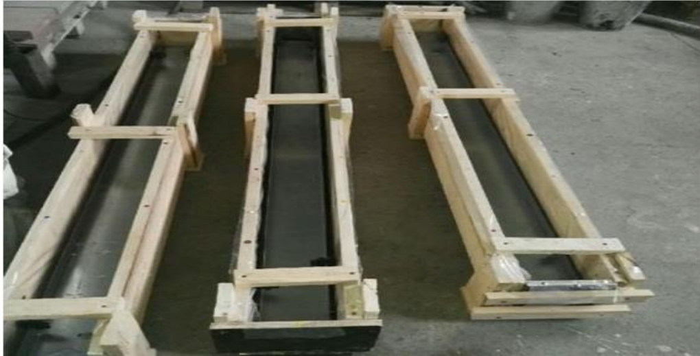
Рисунок 2.25 – Формы балок серии П 1 до бетонирования
