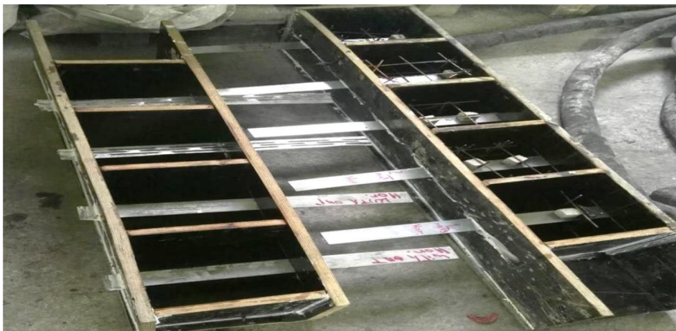
Рисунок 2.8 – Опалубка и установленные полосы для заливки опытных образцов
